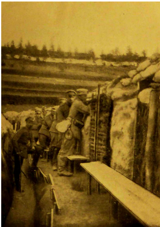
Graben zwischen Bergnase 1 und 2
