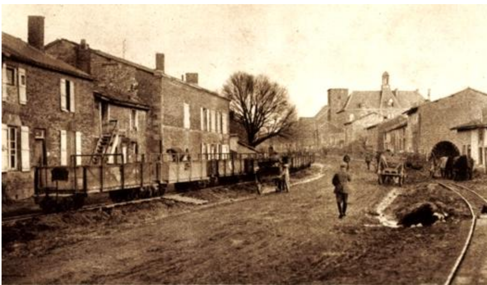
Eisenbahngleise auf der Hauptstraße in Monthois
